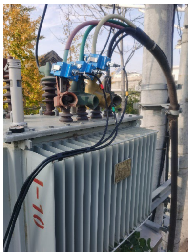
图2: 应用于江苏某农村10KV变压器的户外开合式电流互感器
