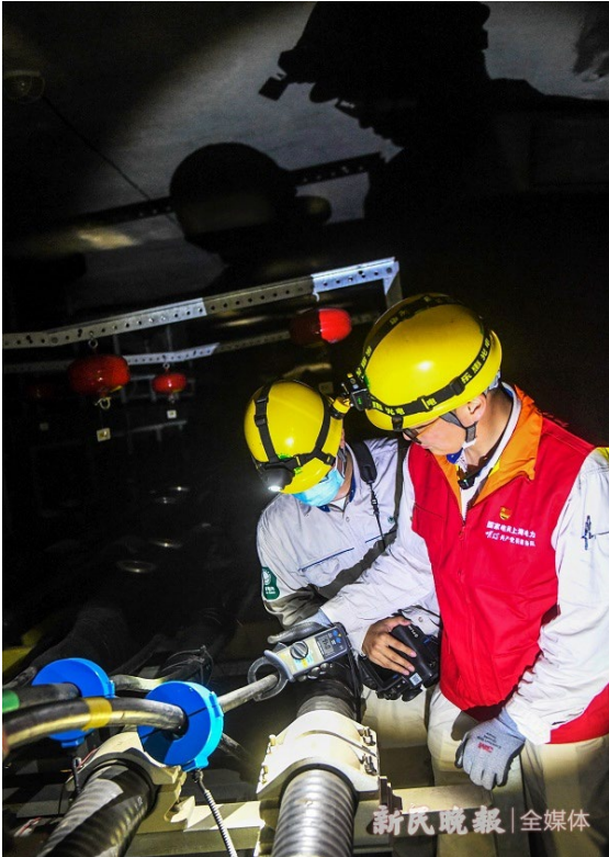
图 3：应用于隧道护层环流监测的户外开合式电流互感器
