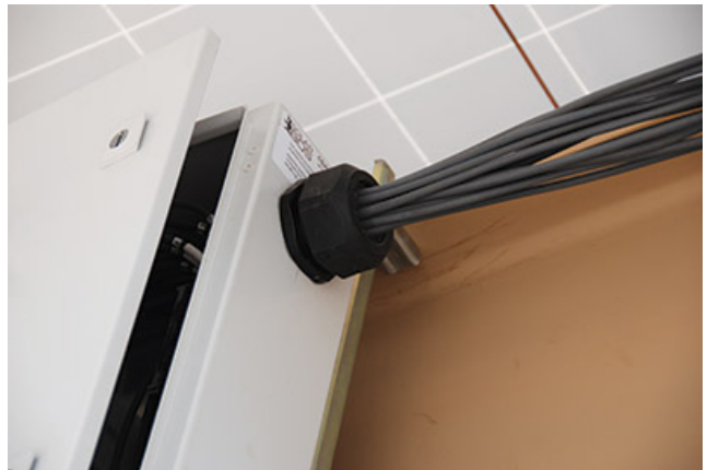
图 7. 适用于进入直流合路器的裸露导线的端接头。
