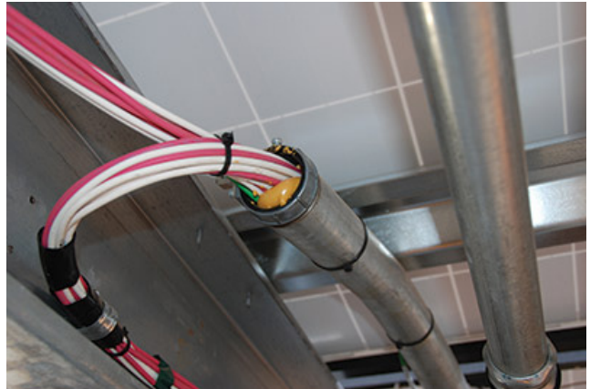
图 6. 许多潜在问题：用于固定电缆束反 EMT 夹具和胶带，塑料扎带，泡沫密封剂和彩色（非黑色）PV 电线绝缘体。
