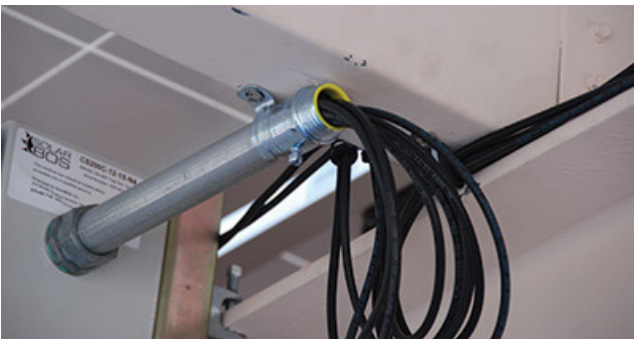
图 5. 不应使用开路导管进入直流合路器。
