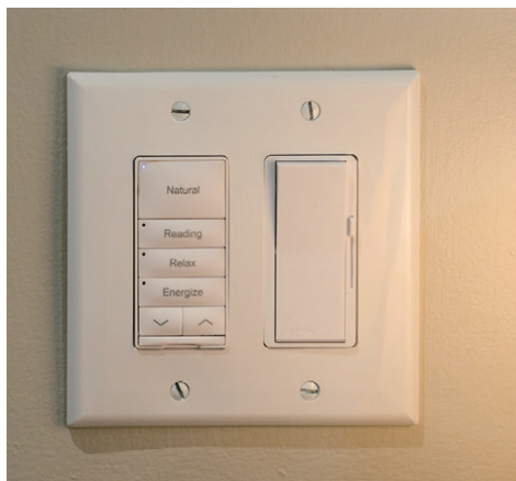
图 3 生活空间中的控制面板包括可以通过 Ketra 软件设置的典型场景以及可以与白炽灯或卤素灯一起工作的传统调光器
